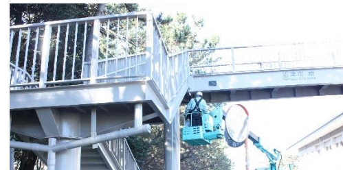
横断歩道橋点検
