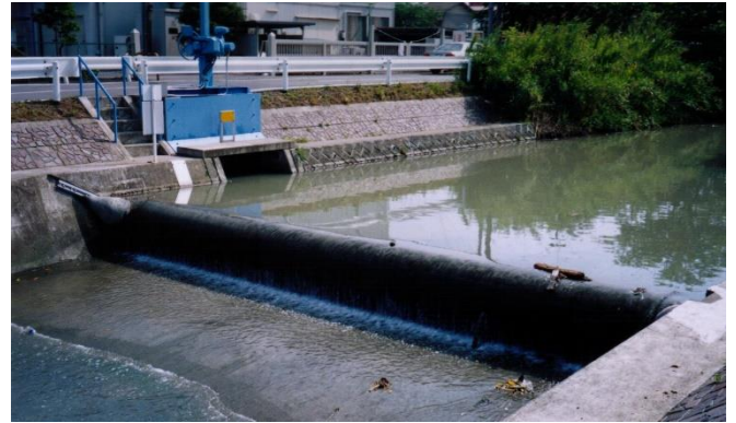
頭首工・樋門
