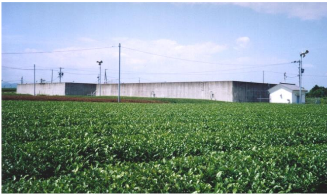
畑地かんがい施設（ファームポンド）
