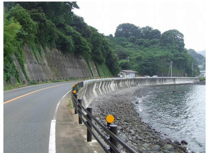
道路各拡幅 (くの字擁壁)
