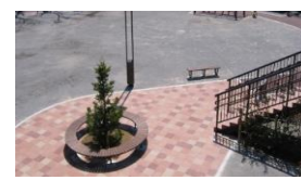
←公園整備 施工後
