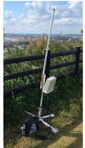
LoRa基地局の通信試験状況
