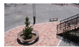
←公園整備 施工後
